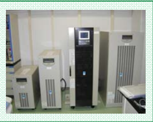
海洋コア無停電電源装置設置
