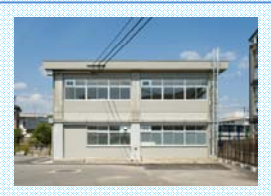
地震観測所改修
