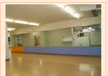
学生食堂改修
