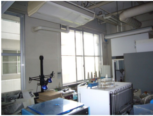
A棟 実験室 不在時窓開放し空調停止
