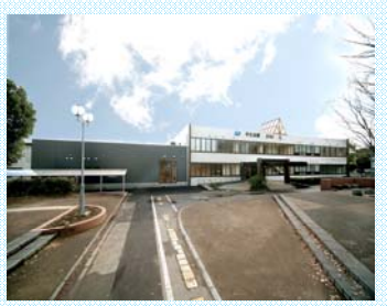
学生会館改修
