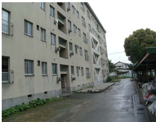
耐震工事が完了した小津宿舎
