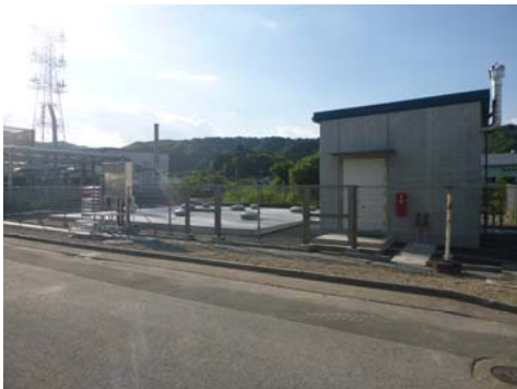
外観（地下燃料タンク）
