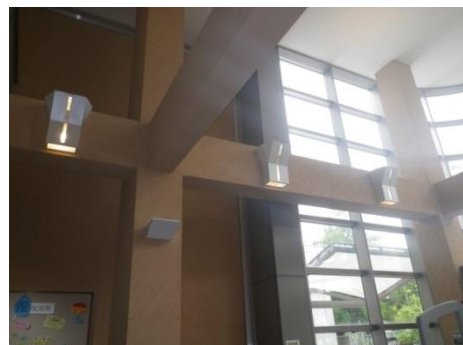
玄関ホール照明
