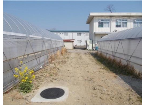
改修後(生活排水枡)
