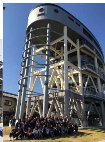
佐賀地区津波避難タワー
