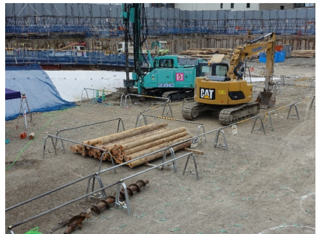
写真-1 LP-LiC工法の施工例 (高知市新庁舎建設液状化対策工事)
