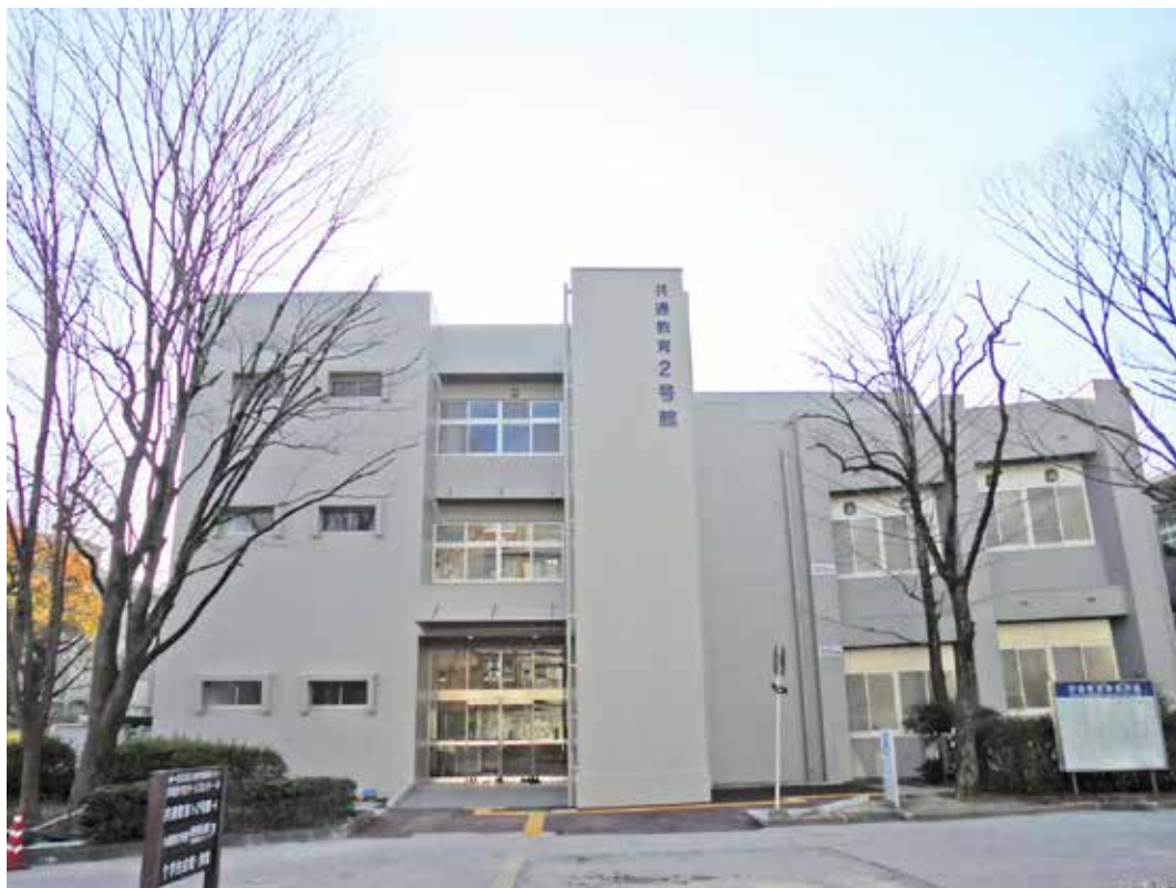
改修工事の終わった共通教育2号館
