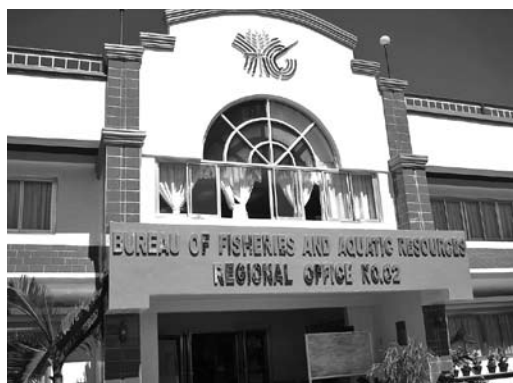
BFAR 第 2 地域支所の建物
